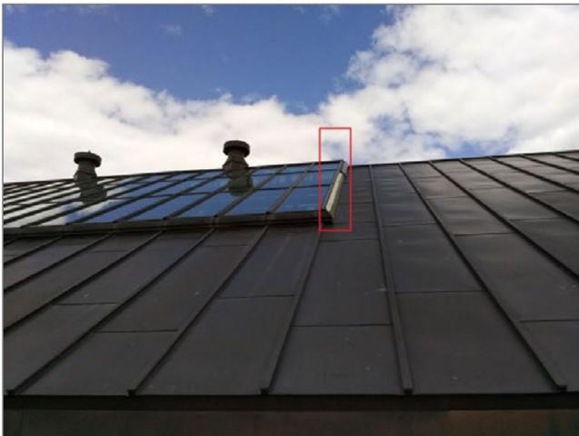
Une section de solin métallique est arrachée à la jonction de la verrière.
