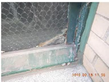
Photo 14 : Types 8 et 8A - Verre broché bosselé avec des fils disposés en forme hexagonale
