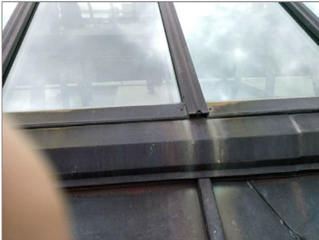
Vue rapprochée du point bas de la verrière. Le scellant est asséché et fissuré.
