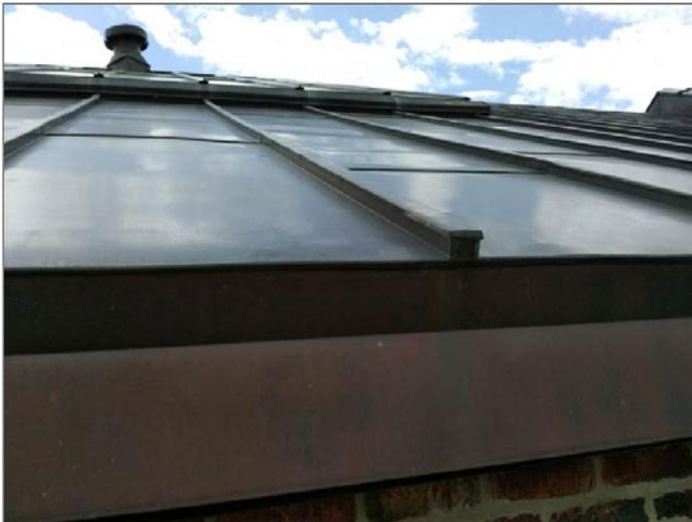
Vue rapprochée du profil d'attache à baguette de la toiture.
