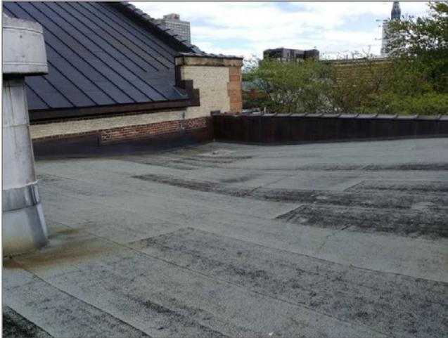
La membrane est usée à plusieurs endroits. Le conduit de cheminée mal scellé.
