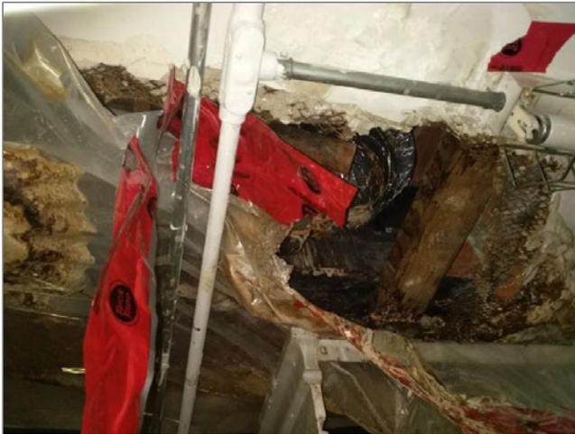
Vue de la zone d'infiltration d'eau sous le bassin.
