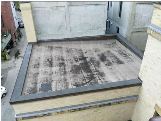
Vue d'ensemble du bassin. La membrane est en mauvais état. La membrane est usée. Présence d'une réparation inadéquate. Présence de débris au drain.
