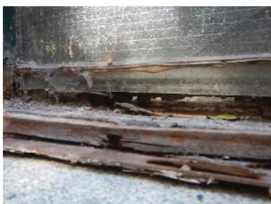
Photo 16 : Types 8 et 8A - Dégradation du seuil extérieur
